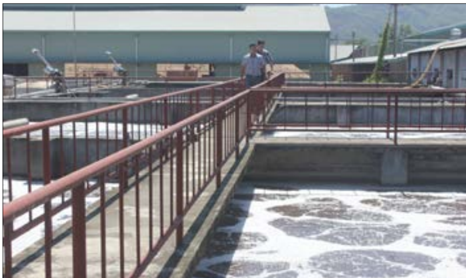
▲ Hệ thống xử lý nước thải của Công ty
